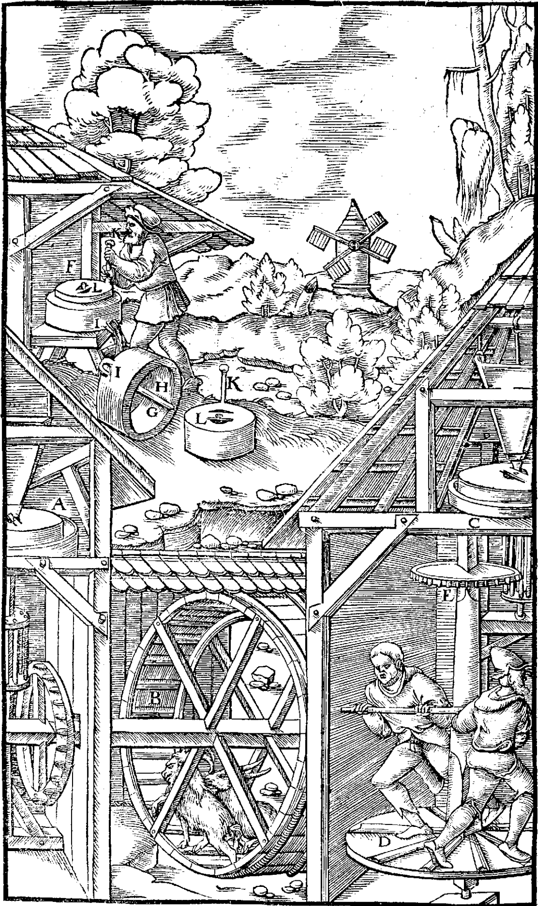
Attamen quidam fabricantur machinam, quæ una auri uenam uno eodemque tempore tūdāt, molat, lauando purget, cum argēto uiuo permisceat aurum
