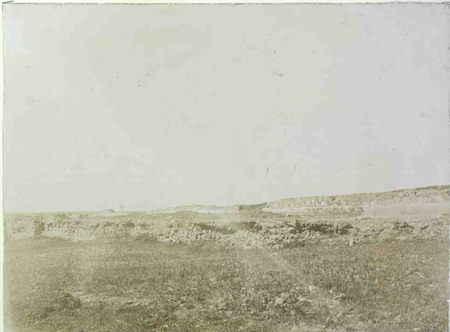
Muralla romana con la canal para la conducción de las aguas, correspondiente al S. (Mérida).
