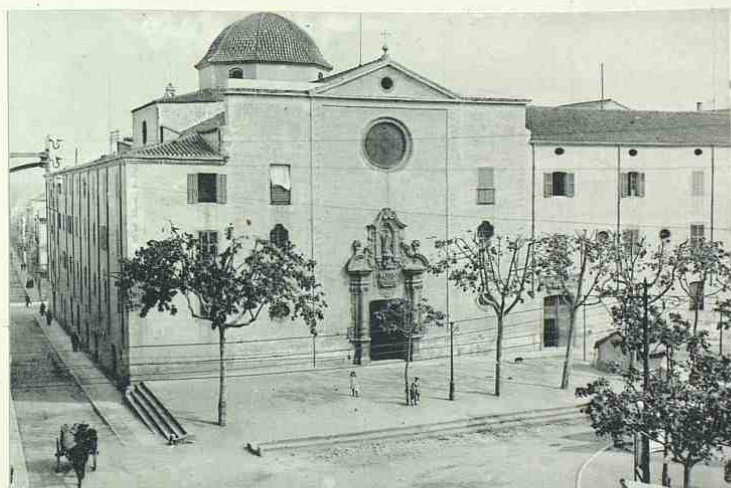
XORRAM - Fachada del Colegio de Escalapios
