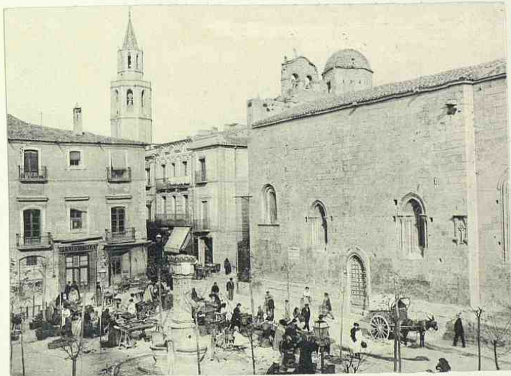
ΧΧΧΜ - Fachada S. de la Iglesia de San Juan
