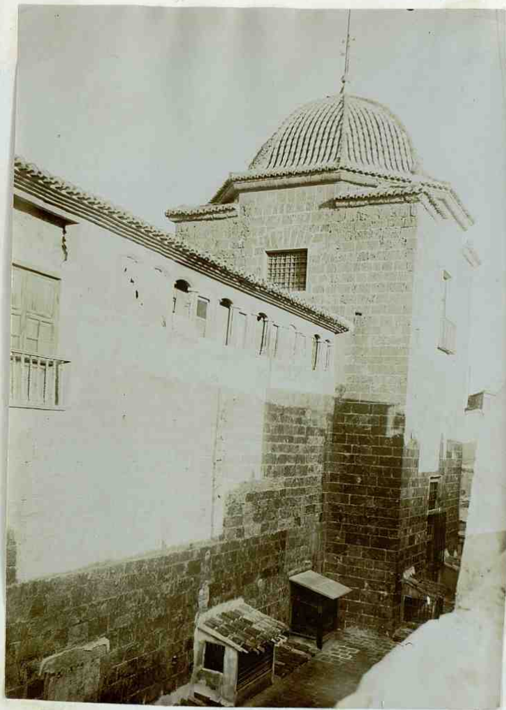
Segorbe. Muro exterior del Claustro y sala Capitular de la Catedral de Segorbe.
