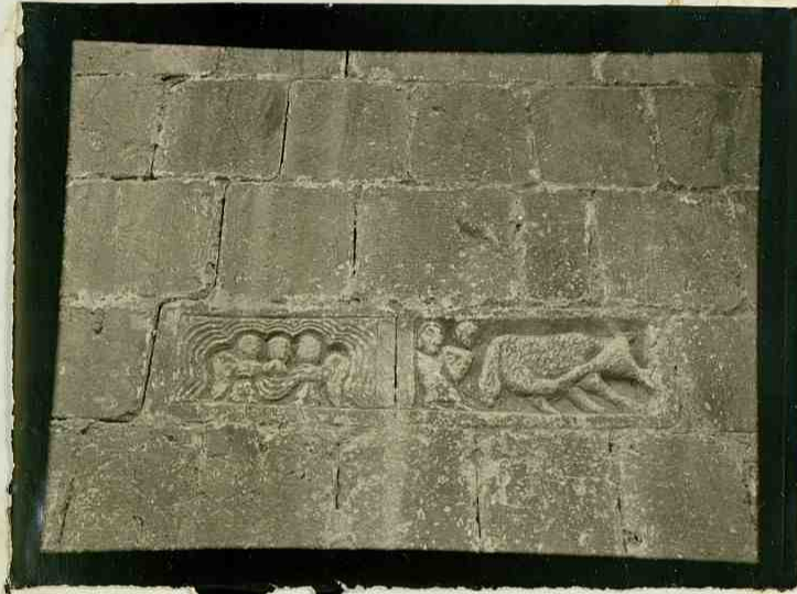
Beaufort. Relieve en el muro de la iglesia dos en el muro de la iglesia
