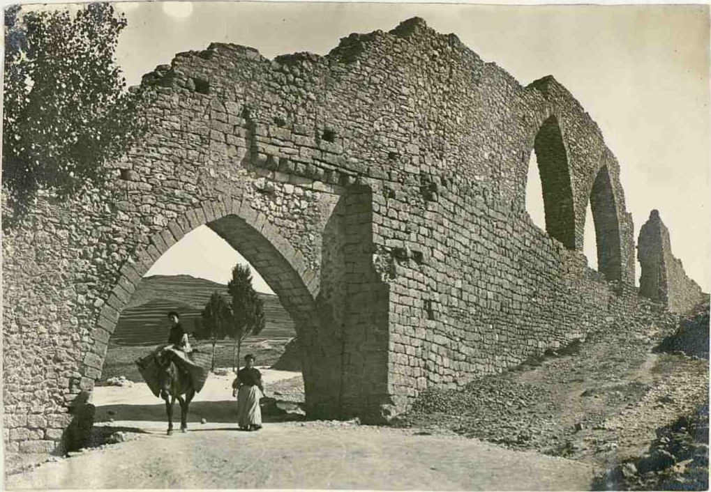
Morella. Arco de paso del acueducto
