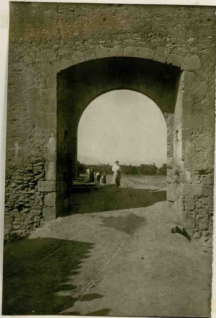
Marcarell. El portal de Nules: aspecto interior
