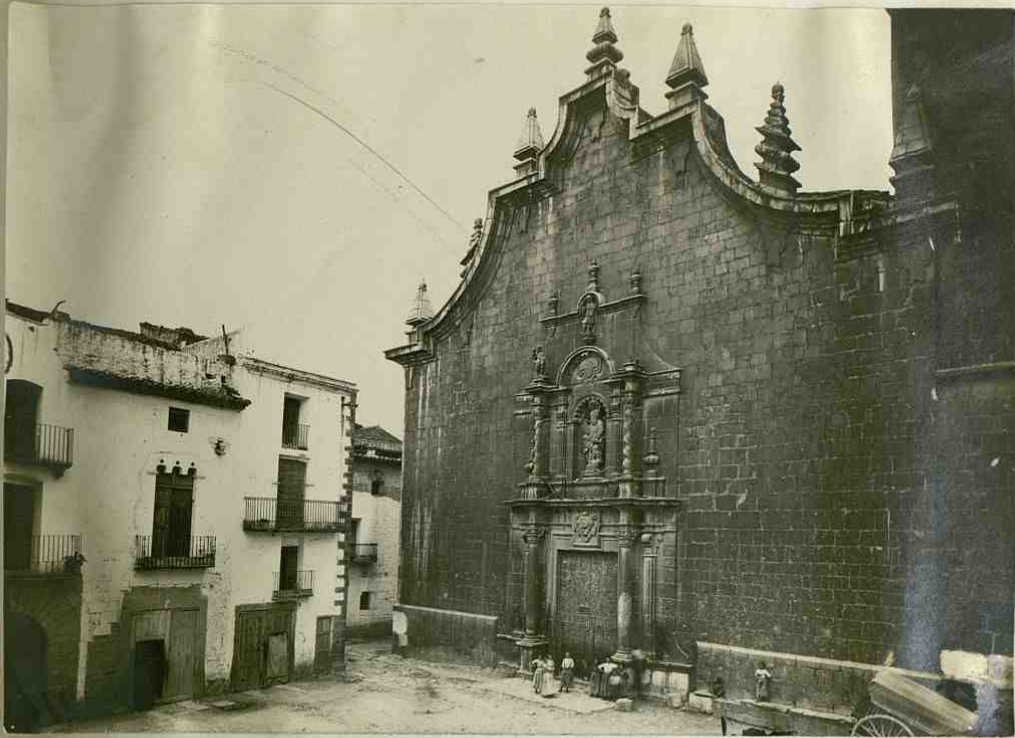
La Jaua. Fachada de la iglesia parroquial
