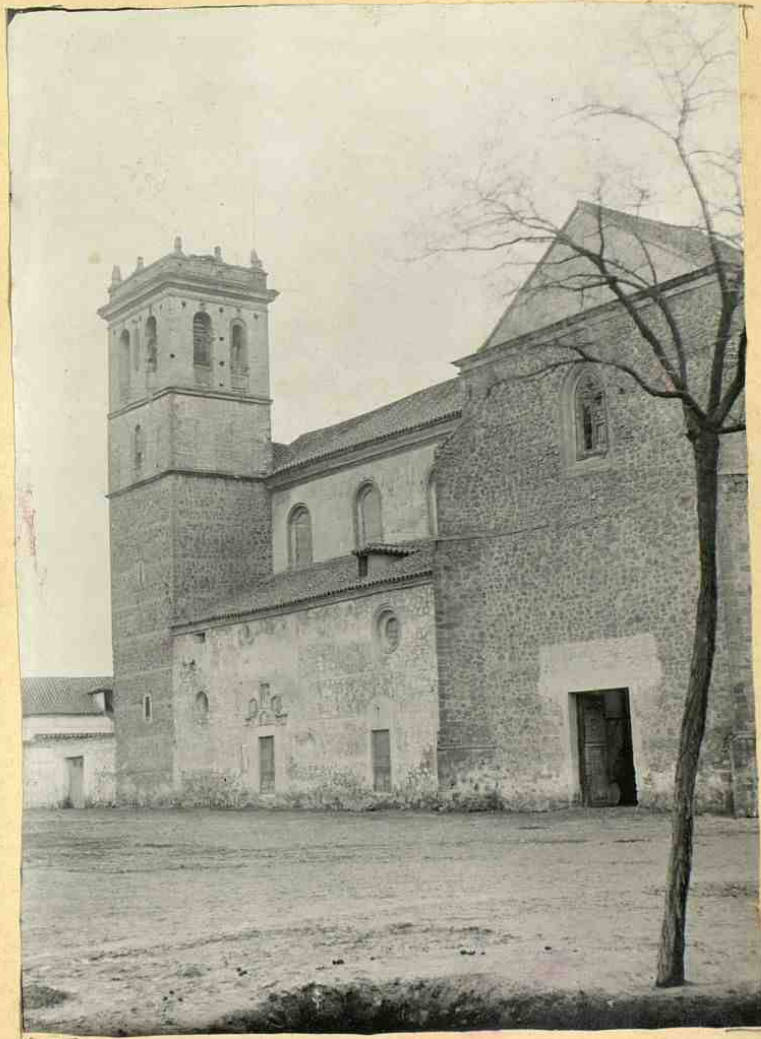
Santo Domingo del Arrabal. (Vista exterior.)
