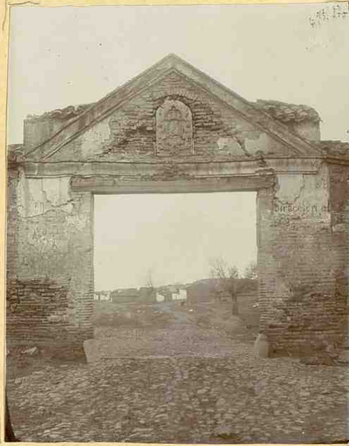
Puerta de la población (Exterior.)
