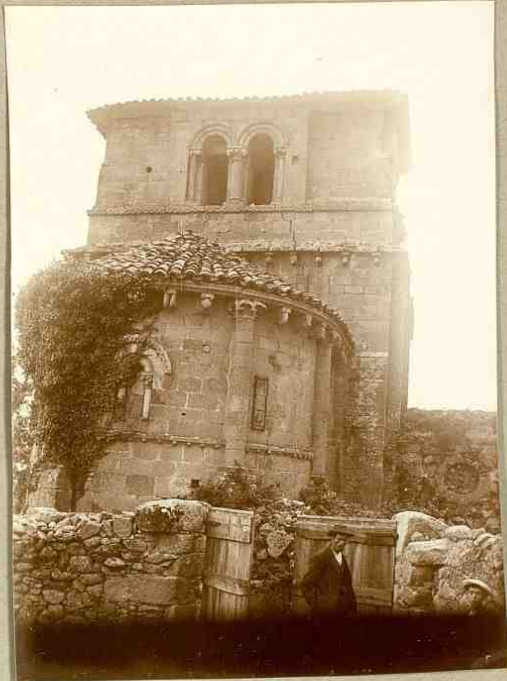
Abside y torre
