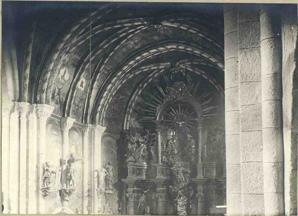
Bóvedas de la capilla mayor
