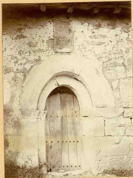
Bastian - Ermita de San Sebastian, cuya fachada está revestida de lapidas romanas.
