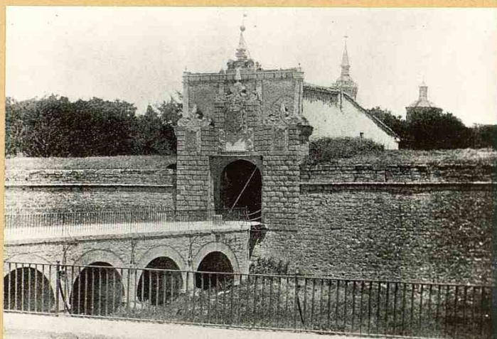
Puerta de la Esconera como se conserva en la actualidad.
