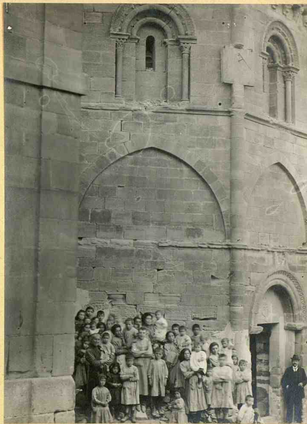
Puerta y ventanas de la iglesia de Templarios.
