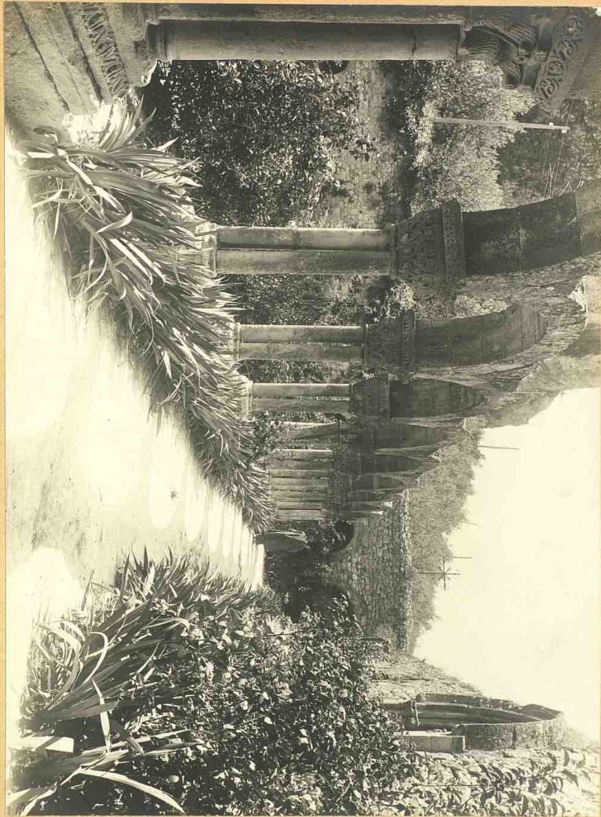
Claustro de San Pedro de la Ruá. (exterior).
