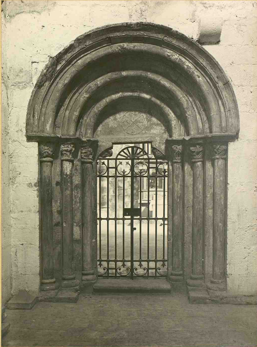
Puerta de la Cripta.
