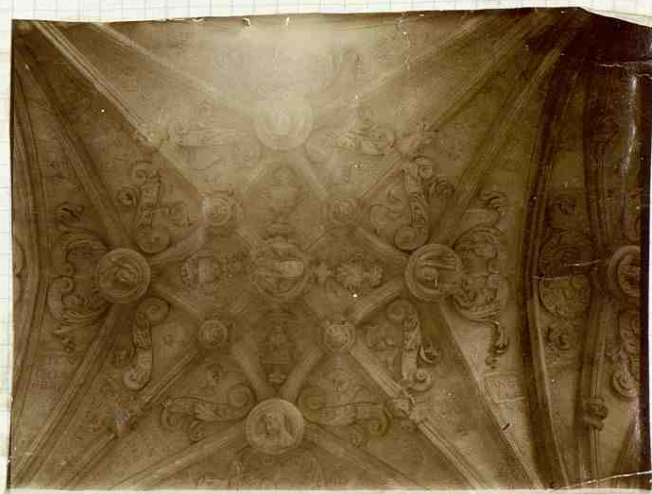
— Bóveda en el Claustro de Carmona
