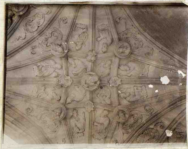
— Bóveda en el claustro de Carmona
