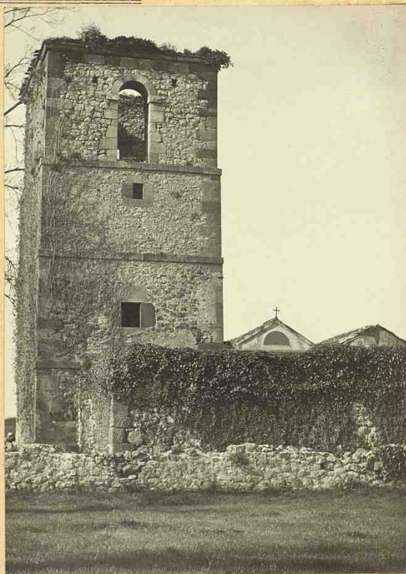
Torre de la iglesia.
